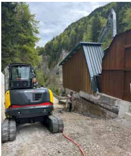
Sanierung Rechenreinigungsgebäude KW Vilsfall
